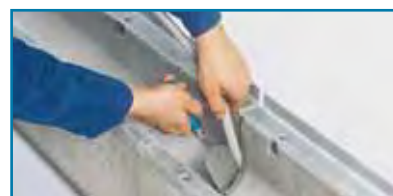
3. Inserting the PE sealing cord
