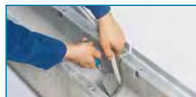
3. Inserting the PE sealing cord
