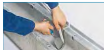
3. Inserting the PE sealing cord
