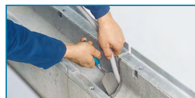
3. Inserting the PE sealing cord
