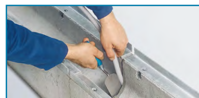
3. Inserting the PE sealing cord
